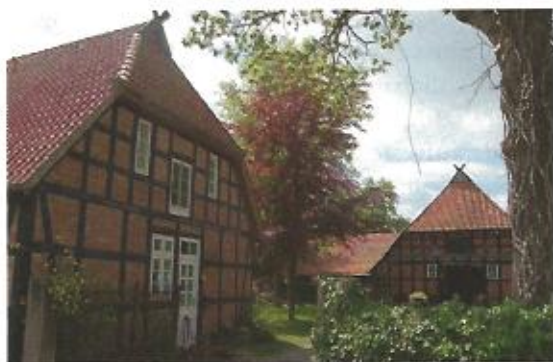
M 3: Fachwerk-Bauernhaus in Otersen
